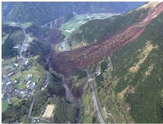
崩落した阿蘇大橋
